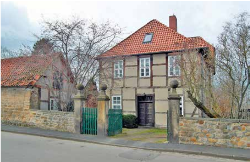
Das Herrenhaus des Unterguts in Egestorf in der Schmiedestraße 15 ist ein schlichter Fachwerkbau, der vermutlich im 18. Jahrhundert errichtet wurde. 11
