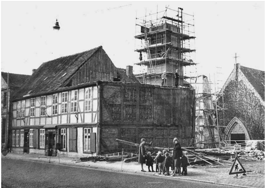
Bilder vom Abbruch des Hauses Hannoversche Straße 51. Im Hintergrund wird gerade der Turm der Martin-Luther-Kirche errichtet, 1962 (Foto: Stadtarchiv Celle).
