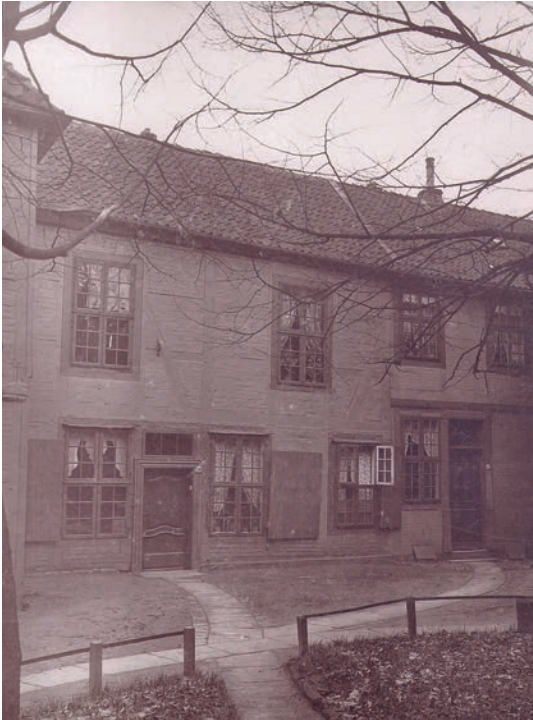
Die Eingänge der Häuser Nr. 59 und 60 liegen auf dem Kirchenvorhof, Foto um 1900 (Evangelisch-reformierte Kirchengemeinde Celle).
